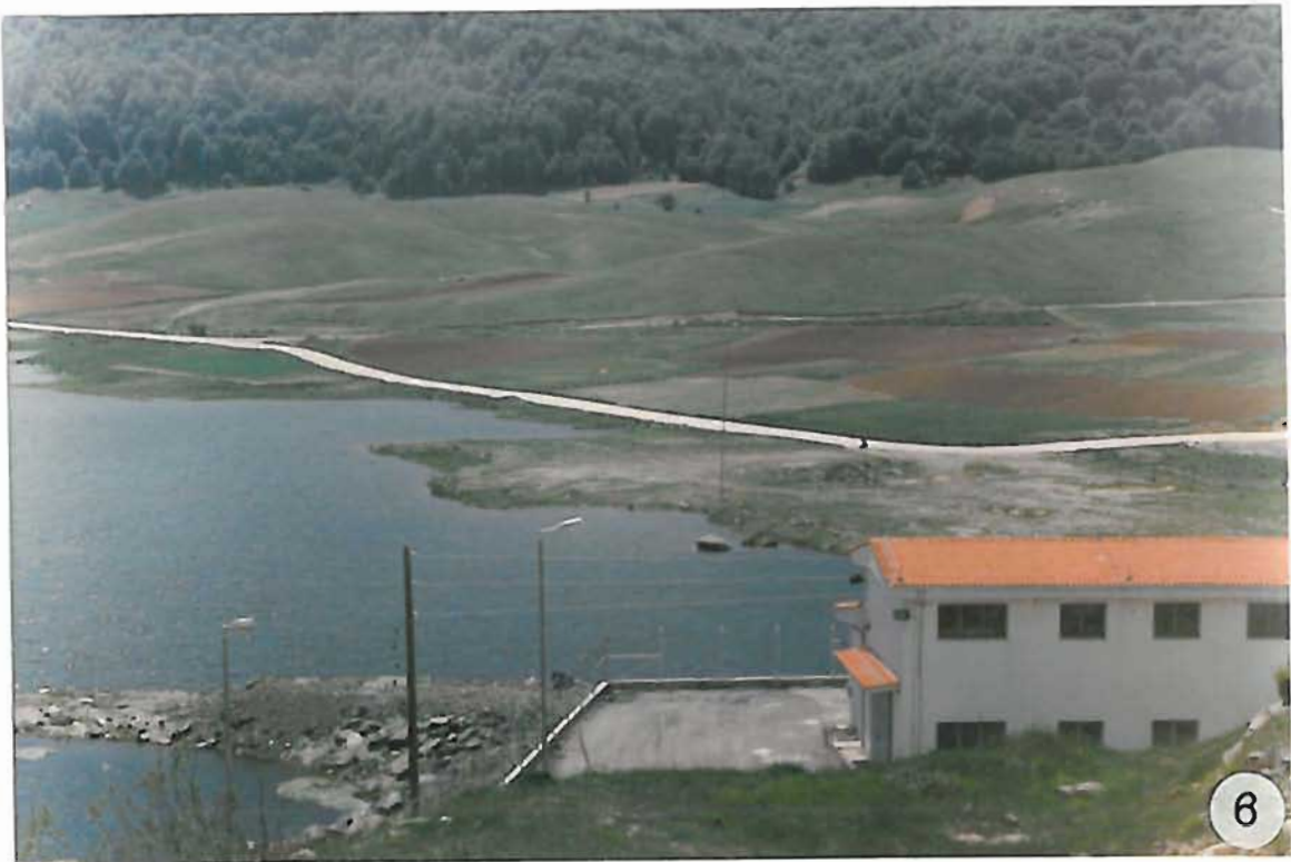
Εικόνα 55. (α) Λεκάνη όπου συγκεντρώνονται οι απορροές μιας γεωργικής έκτασης δίπλα από τον ταμιευτήρα του Αώου. (β) Το αντλιοστάσιο που διοχετεύει τα νερά της λεκάνης στον ταμιευτήρα.
