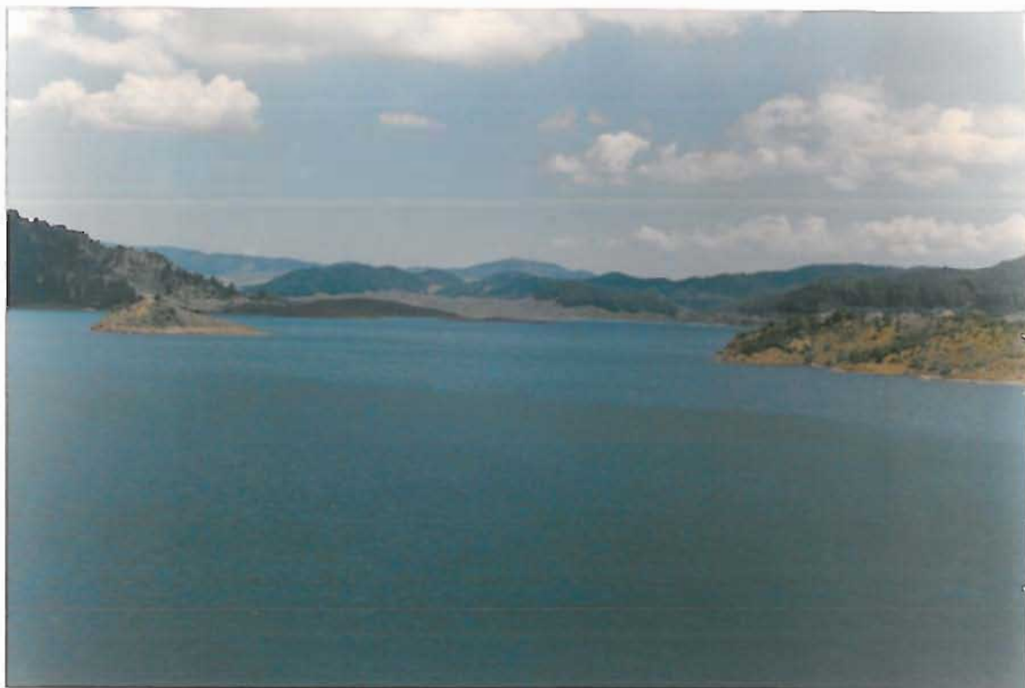
Μερική άποψη του ταμιευτήρα του Αώου.
