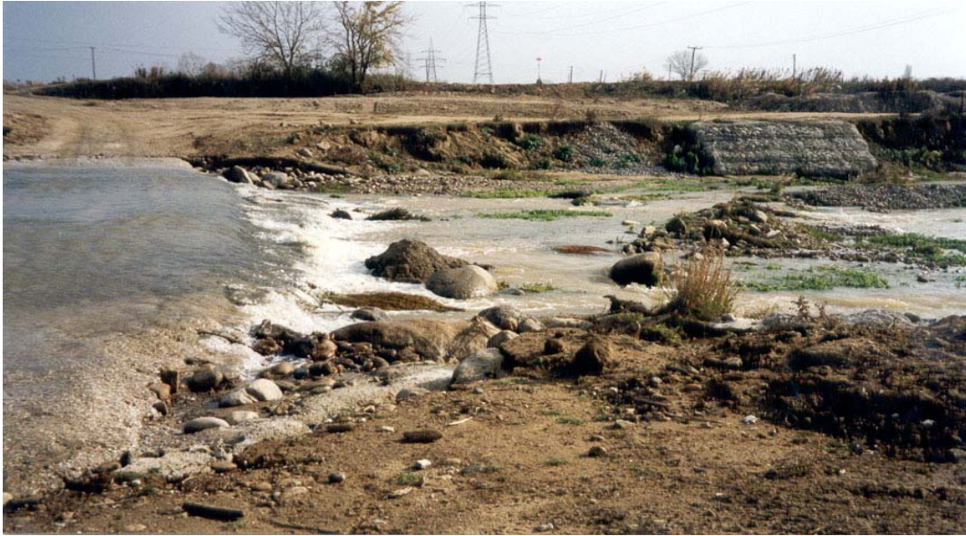
Εικόνα 12. Γενική υποβάθμιση όχθης και κοίτης ποταμού.
