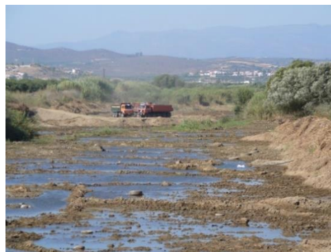
Χαλικοληψίες και αναχωματώσεις (ανάτη της Γέφυρας Σπάρτης)
