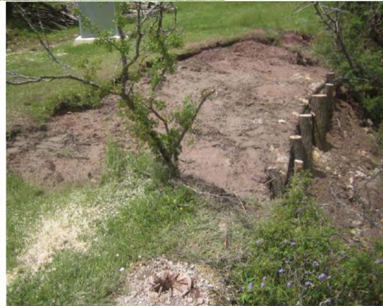
Figura 3.6 Estabilización de taludes mediante la aplicación de técnicas de bioingeniería en Allepuz (CH Júcar): antes del comienzo de las obras y durante su realización
