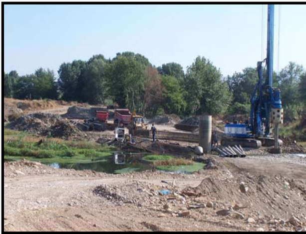
Εικόνα 9. Κατασκευή γέφυρας στη περιοχή Σκούρα
