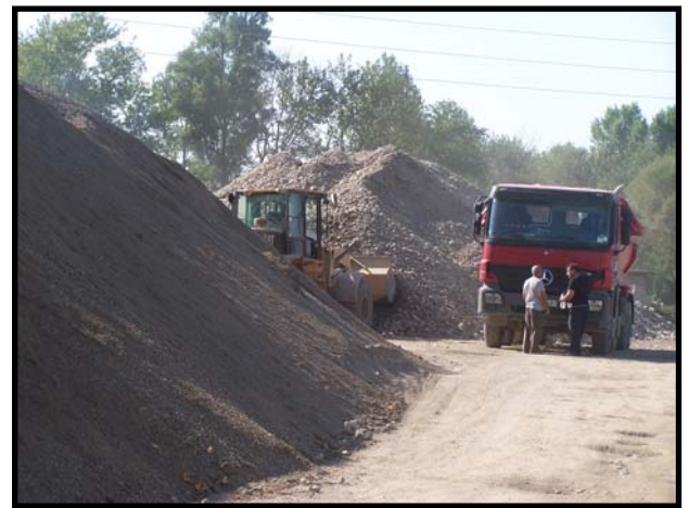
Εικόνα 10. Απομάκρυνση αδρόκοκκου υλικού από τη περιοχή Σκούρα για την κατασκευή του οδικού δικτύου
