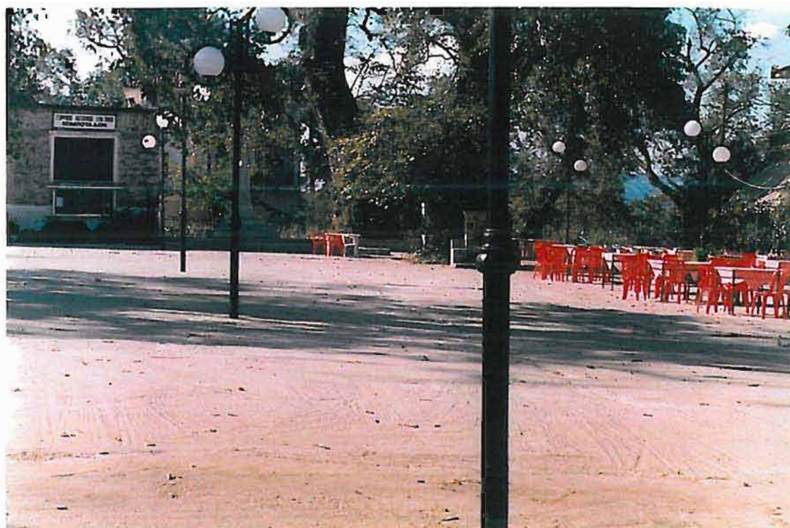
Εικόνα 79 : Η πλατεία του χωριού Κομποτάδες, που κατασκευάστηκε ακριβώς επάνω στο χώρο των πηγών.
