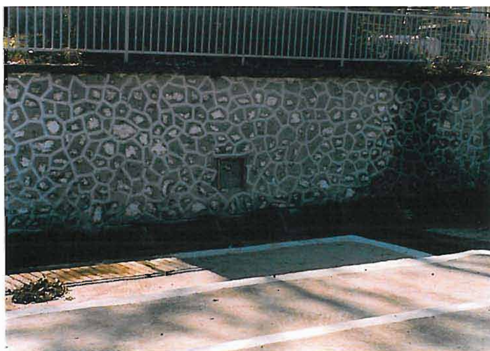
Εικόνα 80 : Η σημερινή έξοδος των νερών της κεντρικής πηγής μετά την κατασκευή της πλατείας Κομποτάδων.
