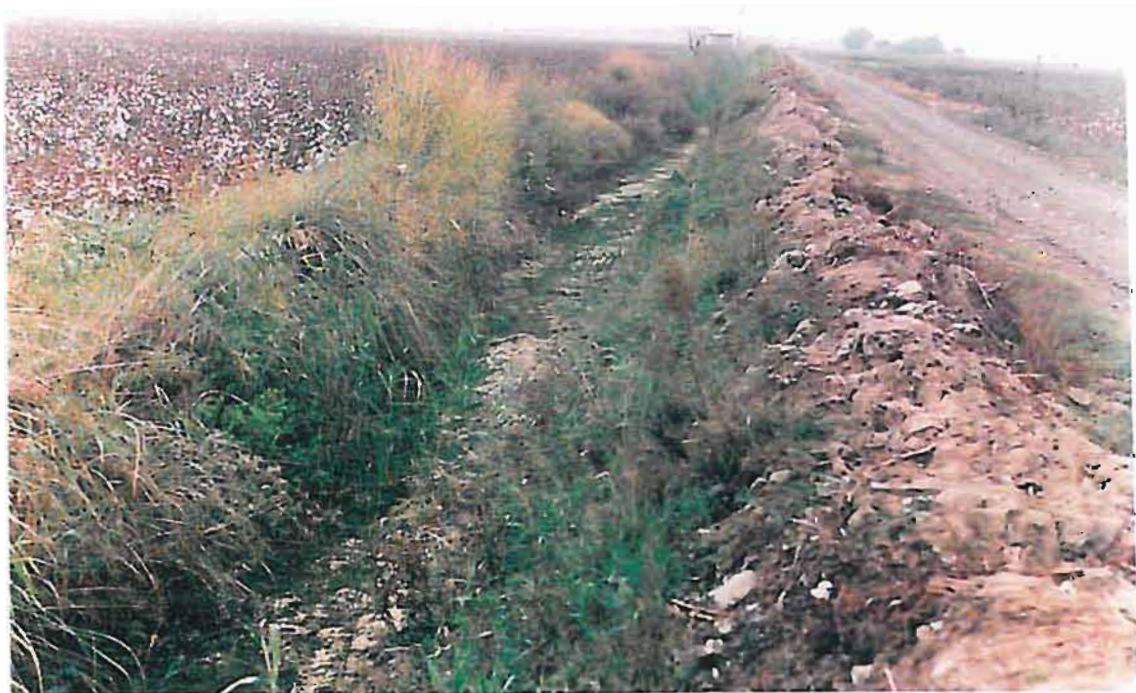
Εικόνα 78 : Διαχειριστικά έργα σε τάφρους Μοσχοχωρίου : αποψίλωση (επάνω) και εκ περιτροπής ξήρανση (κάτω).
