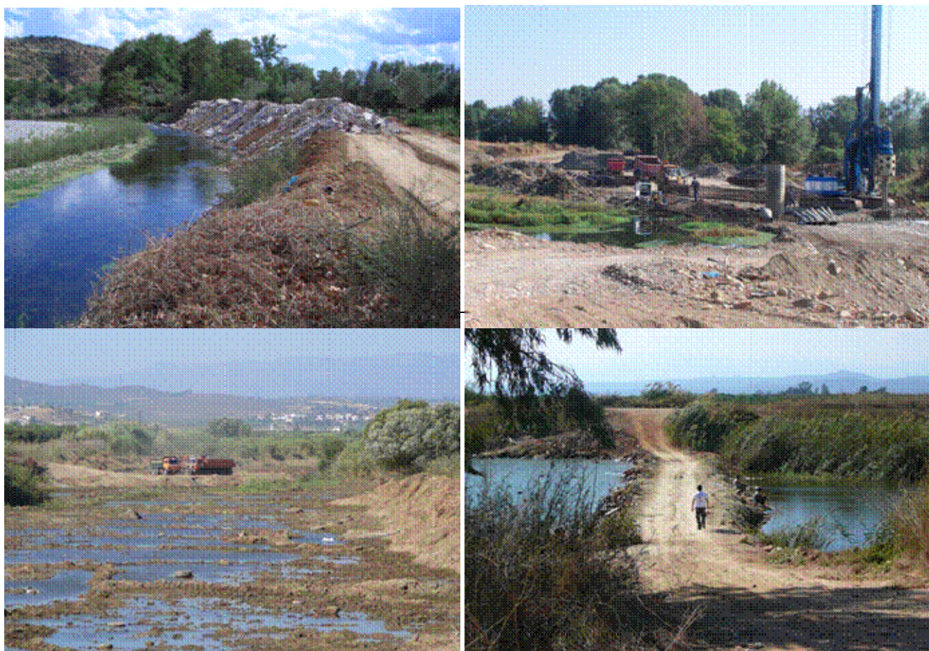
Εικ. 8: Μορφολογικές τροποποιήσεις στη κοίτη του κύριου ρου του Ευρώτα. Πάνω αριστερά: απομάκρυνση υλικού από τη κοίτη κοντά στη ΜΕΑΛ της Σπάρτης. Πάνω δεξιά: έργα κατασκευής γέφυρας στα Σκούρα. Κάτω αριστερά: αμμοληψίες στο κάτω ρου. Κάτω δεξιά: χωμάτινο ανάχωμα εγκάρσια στο ρου του Ευρώτα στις εκβολές.
